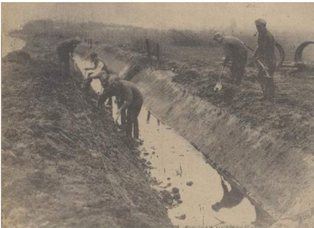
Full speed is men aan het graven van de afwateringssloot, om het overtollige water vanuit den polder bij Nijbroek, in de Wetering te loozen, opdat het 's winters onder water staan van de weilanden, tot het verleden gaat behooren.
