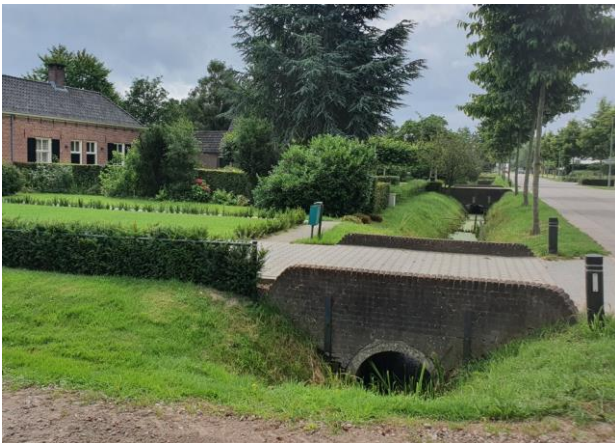
Links en rechts: duikers bij het rijtje Diaconiehuysjes Middendijk 44-50 (gemeentelijk monument); de gemetselde wanden met afgeronde hoeken zijn aan de straatzijde naar buiten afgebogen.
