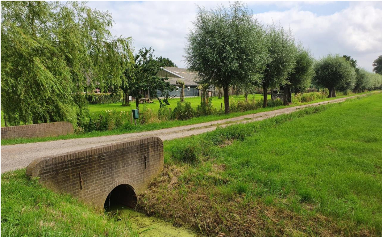
Dam en duiker; Middendijk 28
