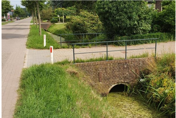
Links en rechts: duikers bij het rijtje Diaconiehuysjes Middendijk 44-50 (gemeentelijk monument); de gemetselde wanden met afgeronde hoeken zijn aan de straatzijde naar buiten afgebogen.
