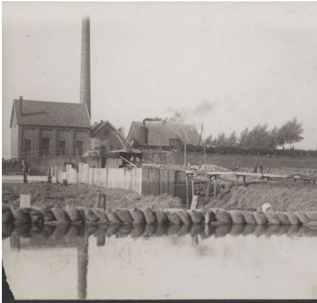
Werkzaamheden t.b.v. nieuwe persleiding (september 1927). Op bovenstaande foto is ook een houten gebouw rechts van het ketelhuis te zien, waarschijnlijk was dit de machinistenwoning (en/of kolenloods). Uit: Nationaal Archief
