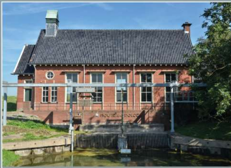
Gemaal Houtrakpolder [beeldbank Rijksdienst voor het Cultureel Erfgoed].
